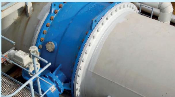
Quand un opérateur doit s'introduire dans un ouvrage du réseau d'eau, il faut fermer deux vannes en amont de sa zone d'intervention, de manière à éviter les accidents imputables à une mauvaise
